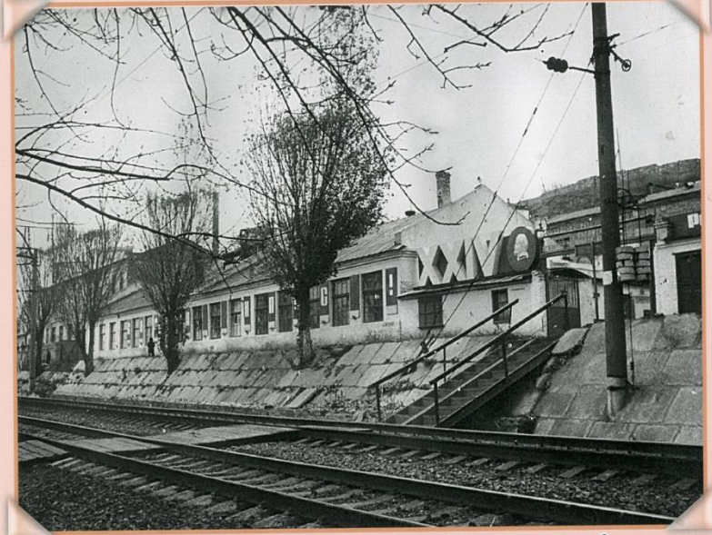
1971 г. Здание блока цехов, пристроенный магазин и проходная Аксайской РЭБ флота.
