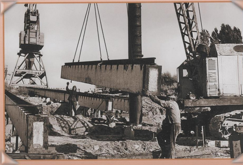
1990-1991 гг. – Модернизация слипа. Строительство дополнительных трех наклонных дорожек слипа. Это позволило поднимать судна с доковым весом до 2200 тонн и длиной до 145 метров. До модернизации поднимались суда с доковым весом до 1600 тонн и длиной 100-110 метров.
