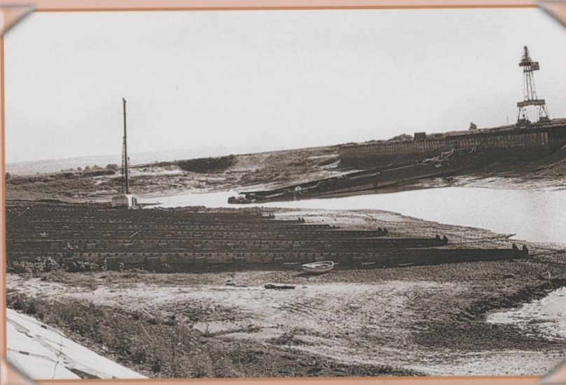
1990-1991гг. Осушение котлована для строительства дополнительных трех наклонных дорожек слипа.
